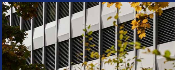
Rénovation complète de l'immeuble datant de 1976.
